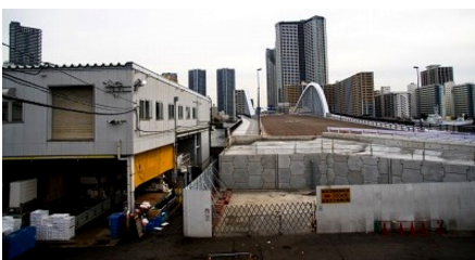
市場の建物内から工事中の環状2号線が見える。豊洲に渡る道路だが、築地市場にぶつかって未開通、急カーブのバイパスは事故が多発すると指摘されている
