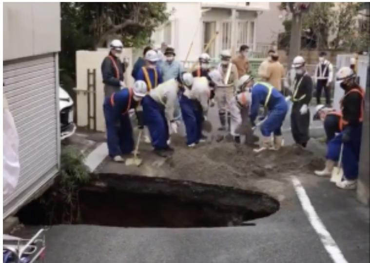
10月18日、外環道のトンネル工事が直下で行われていた調布市の私道が、突然陥没し大問題になっています。この場所は、トンネルを掘るシールドマシンが9月14日に通過し、そのころから数々の異常が発生していました。シールドが通過した外環道の全域で徹底した調査が不可欠です。
